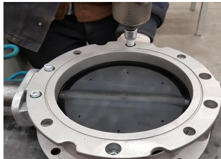
7- Cıvata ve somunları takınız. 7- Fix bolts and nuts and tighten.
